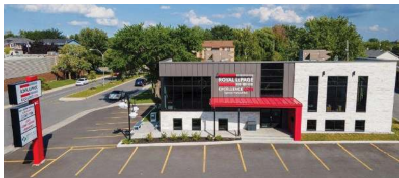
943 blv. du Séminaire Nord, Saint-Jean-sur-Richelieu
