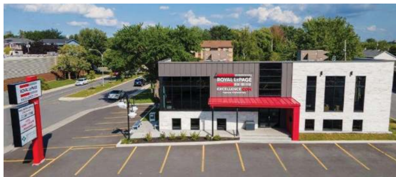
943 blv. du Séminaire Nord, Saint-Jean-sur-Richelieu
